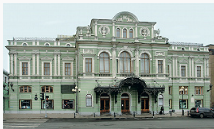
Здание Санкт-Петербургского Большого драматического театра. 1876–78. Архитектор Л. Фонтана. Фото А. И. Нагаева
