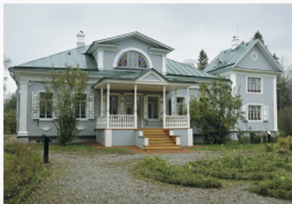
Шахматово. Главный дом.
