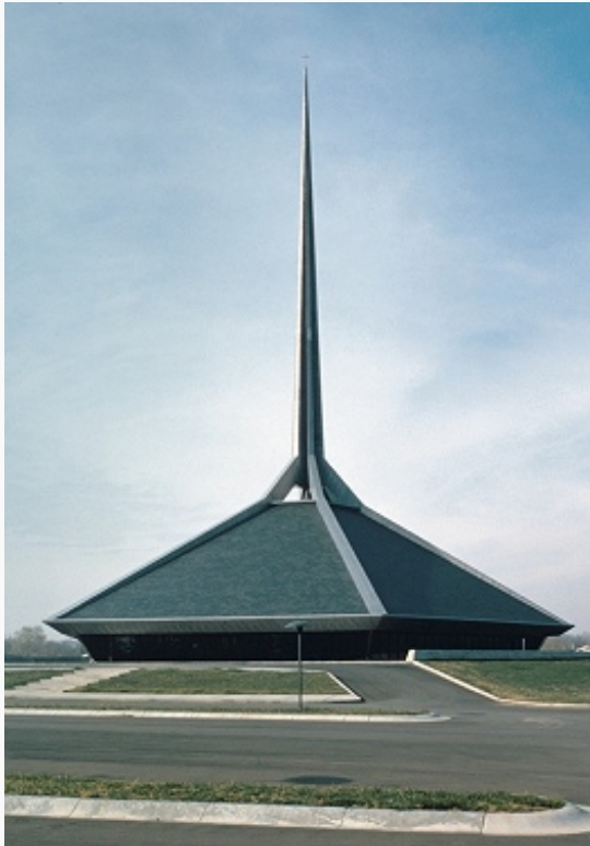
Фото Balthazar Korab Северная христианская церковь (Ученики Христа) в Колумбусе (штат Индиана). 1964. Архитектор Э. Сааринен.
