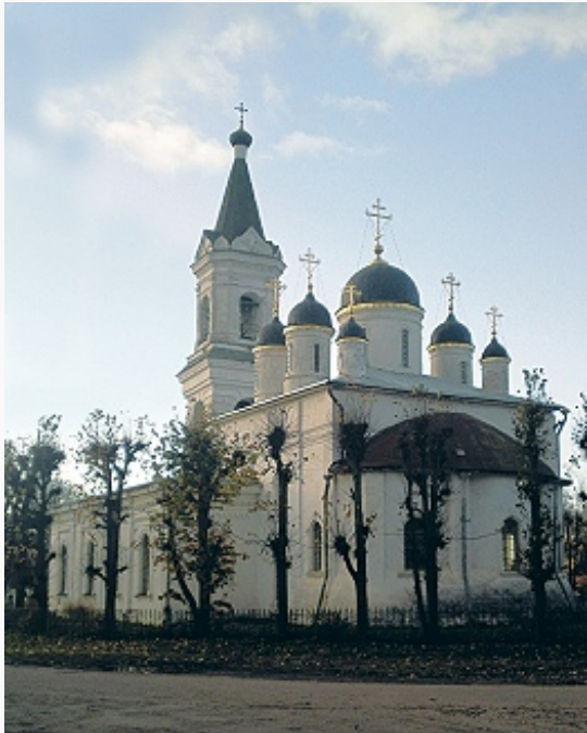
Церковь «Белая Троица». 1563. Колокольня – 1812 (надстроена в 1878).
