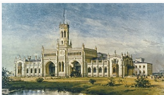
Вокзал станции Новый Петергоф Петергофской железной дороги (1854–57). Архитектор Н. Л. Бенуа.
