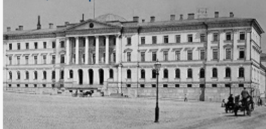
Здание Сената Великого княжества Финляндского. Гельсингфорс. Архитектор К. Л. Энгель. 1818–22.
