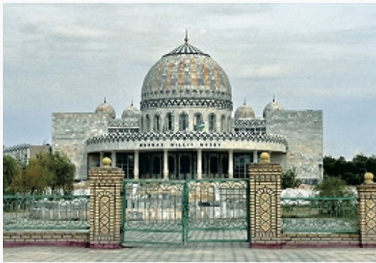
Нукус. Музей поэта Бердаха. 1997. Архитектор О. Торениязов.
