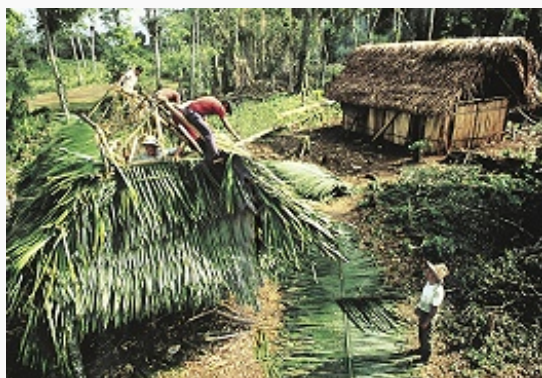
Гватемальцы. Строительство каркасного жилища на участке, расчищенном в джунглях.
