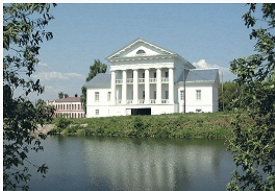
Здание Главного правления пермскими именьями Строгановых в посёлке Ильинский. 1805.
