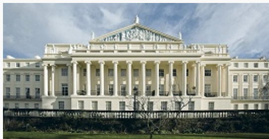
Дж. Нэш. Жилой комплекс Камберленд-террас в Лондоне. 1825.
