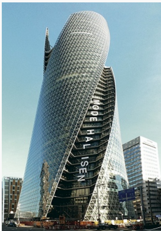
Нагоя. Высотное здание «Mode Gakuen Spiral Towers». 2005–08. Архитектурное бюро «Nikken Sekkei».
