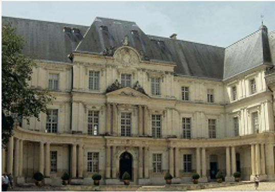
Ф. Мансар. Корпус Гастона Орлеанского в замке Блуа. 1635–38.
