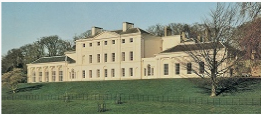
Кенвуд-хаус. Южный фасад. 1764–79. Архитектор Р. Адам.
