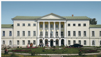
Ивановское. Главный дом. Кон. 18 – нач. 19 вв. Фото. 2007.
