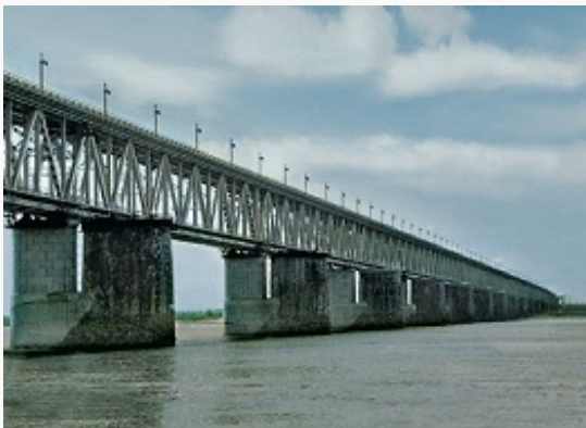
Железнодорожный мост через реку Амур.
