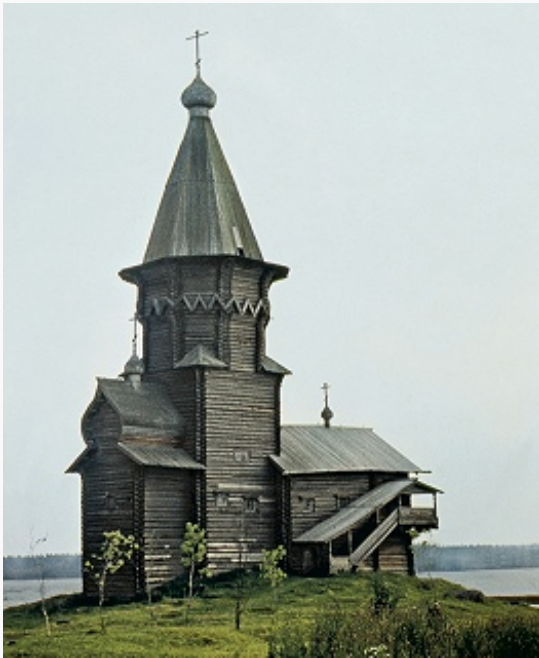
Деревянное зодчество. Успенская церковь в Кондопоге. 1774.
